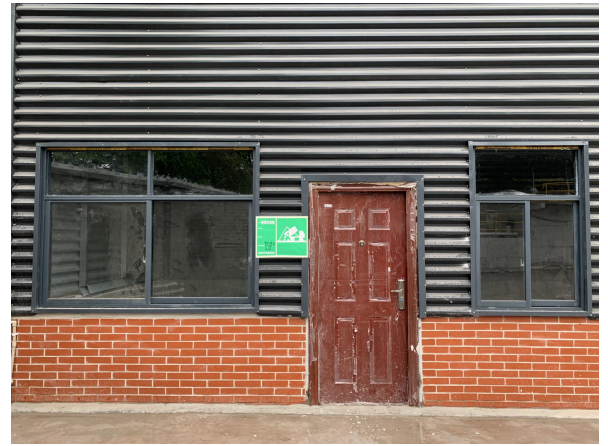
一般固废暂存间
