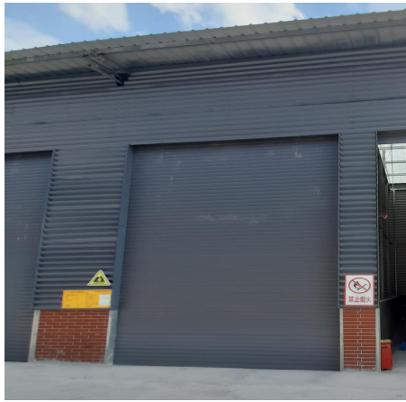
危废暂存间全景
