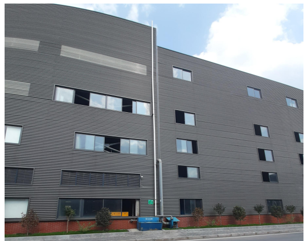
打磨废气排气筒
